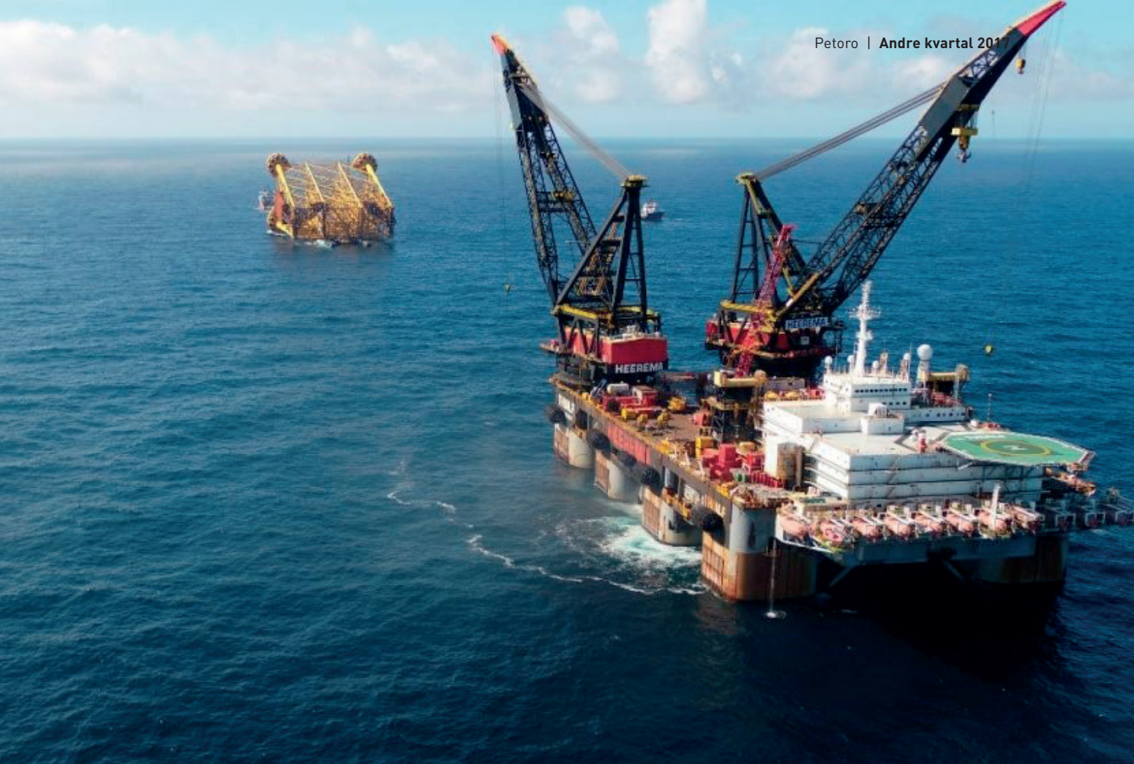
Første synlige tegn på at Johan Sverdrup-feltet tar form i Nordsjøen. Stålundestellet løftes på plass. Kilde: Statoil
